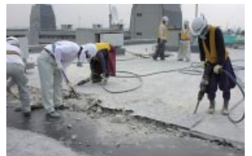
屋上シンダーコンクリート解体中
